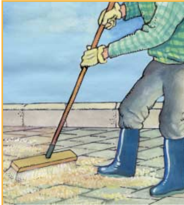
Eliminar el exceso de arena con cepillo.
